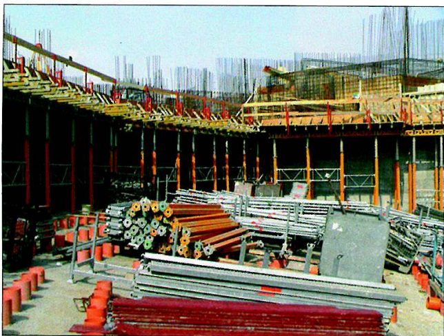
16. Viste le dimensioni dell'intervento e la complessità delle fasi esecutive, in cantiere sono state utilizzate numerose tipologie di attrezzature: in particolare, segnaliamo l'impiego di sistemi Peri - travi, puntelli e pannelli - per la realizzazione degli impalcati.
