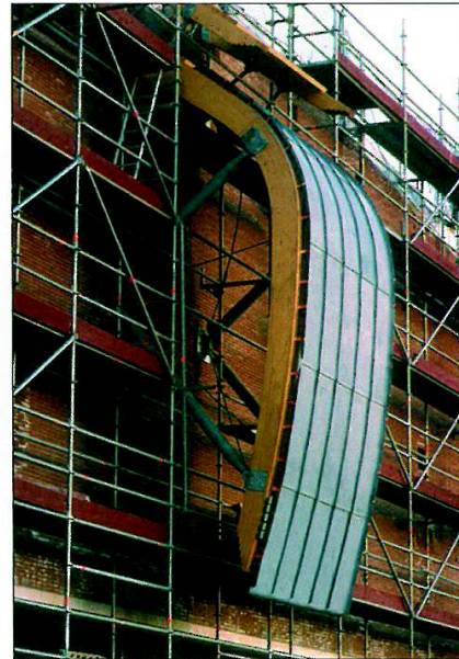
7. La conformazione architettonica monolitica delle sale viene addolcita dal disegno formale della copertura, che a partire dall'orditura superiore scende con elementi coerenti in facciata a determinare un "guscio" avvolgente.
