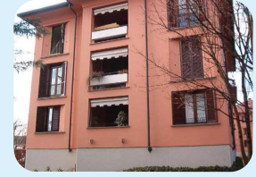
installazione isolamento a cappotto
