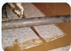
rifacimento fondi di serbatoio
