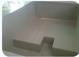
bacini di contenimento secondari
