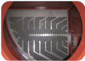
ripristino casse acqua e piastre tubiere
