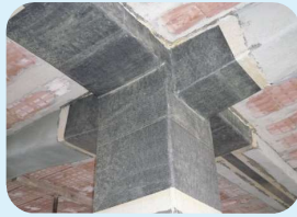
rinforzo con fibre di carbonio
