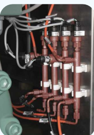
verniciatura tubazioni e fitting
