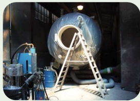
rivestimento interno serbatoi
