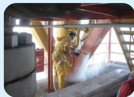
idroscarifica ad ultra pressione
