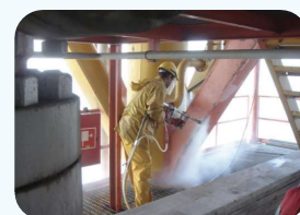
idroscarifica ad ultra pressione
