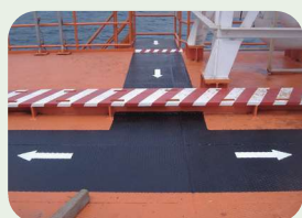
segnaletica di sicurezza
