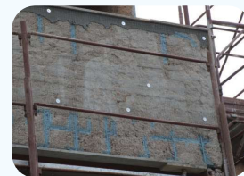
rifacimento calcestruzzi deteriorati
