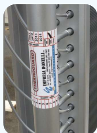
rivestimento anticorrosivo scambiatori
