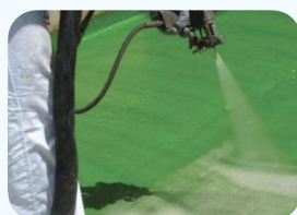
impermeabilizzazione con membrane elastomeriche
