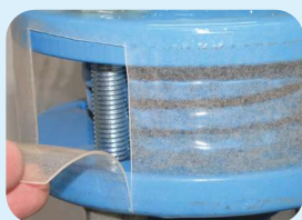
rivestimento flange con Metaline
