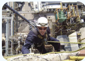
manutenzione senza ponteggi
