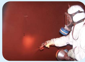
applicazione rivestimenti interni con sistemi per uso alimentare
