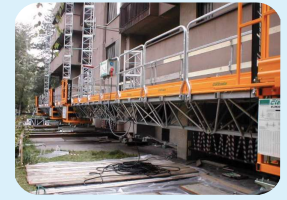
ripristino facciate con ponti rampanti
