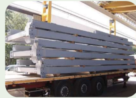
protezione passiva dal fuoco prima del montaggio
