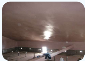
condotti impianti di desolfurazione
