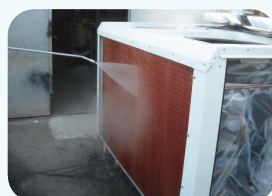
manutenzione impianti di condizionamento
