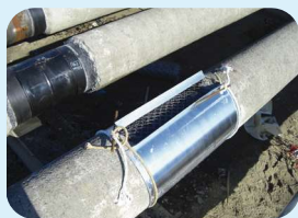
esecuzione field-joint
