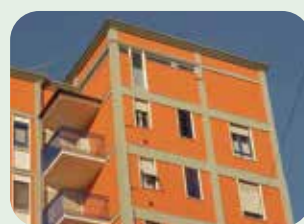
manutenzione facciate con cemento armato
