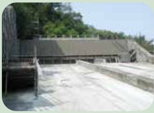
Ripristino calcestruzzi centrali idroelettriche
