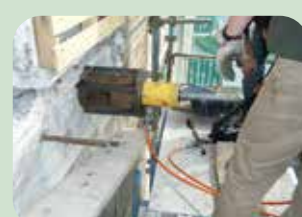
prove distruttive adesione tirafondi
