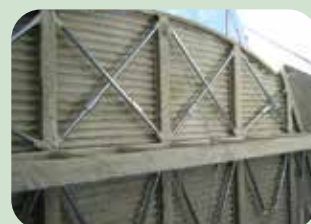
intonaco alleggerito antincendio e coppelle
