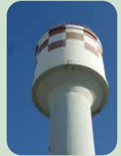
Manutenzione torri piezometriche
