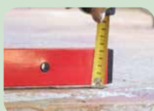
monitoraggio stato di fatto
