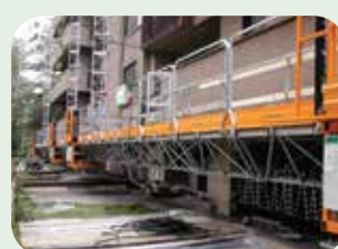
ripristino facciate con ponti rampanti
