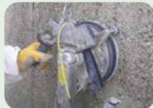
idrodemolizione a recupero
