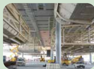
Realizzazione grandi stazioni
