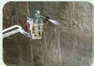
idroscarifica cemento armato
