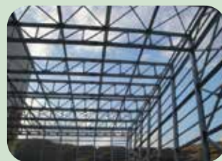
strutture trattate con pittura intumescente prima del montaggio
