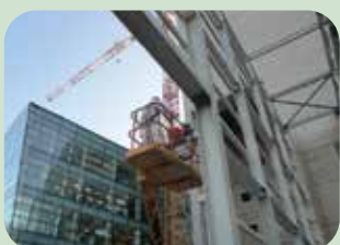
ritocchi pittura intumescente su accoppiamenti
