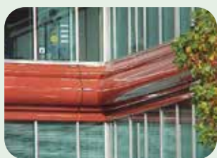
riqualificazione palazzine uffici
