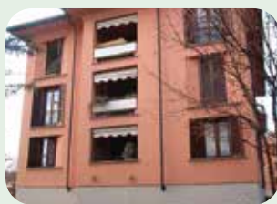
installazione isolamento a cappotto
