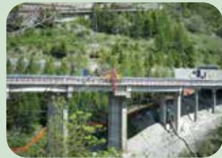
Interventi di ripristino su viadotti
