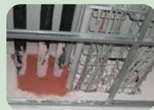
sigillatura passaggio cavi
