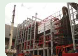
Verniciatura impianti industriali
