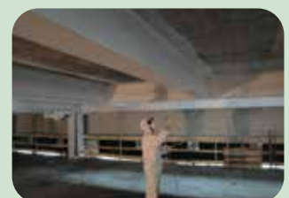
pittura intumescente travi parcheggi
