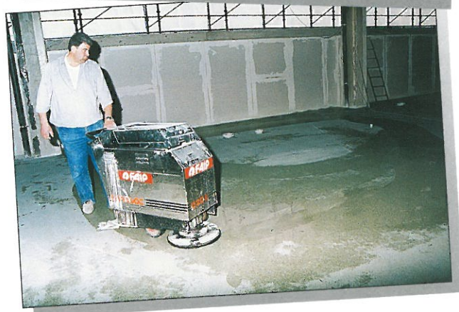
Qui sopra: il lavaggio, fase terminale della posa del pavimento. Operaio dell'Impresa Donelli di Legnano, che ha eseguito la stesura del pavimento.
