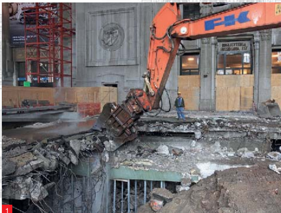
Foto 1. Demolizione della pavimentazione esistente.
