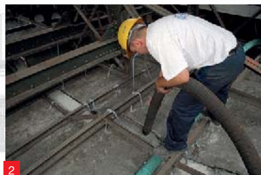
Foto 4. Stesura dell'adesivo MapeWrap 31.
