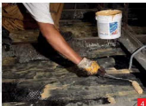
Foto 5. Preparazione per la stesura di MapeWrap C UNI AX.
