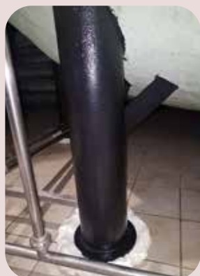
inspections et rétablissements sur revêtements extérieurs
