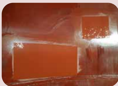
inspections et rétablissements sur revêtements intérieurs
