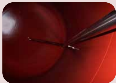
rénovation du revêtement intérieur d'autoclaves et citernes
