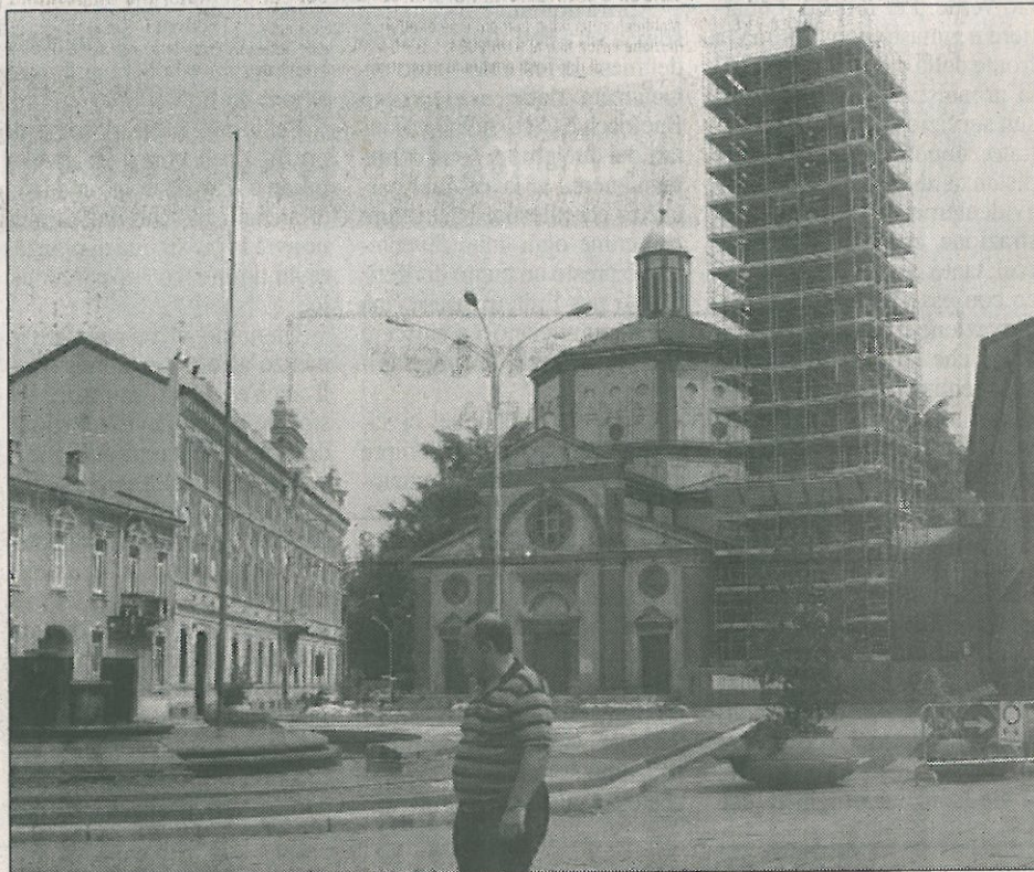
Una grande impalcatura riveste da alcuni giorni il campanile di San Magno
