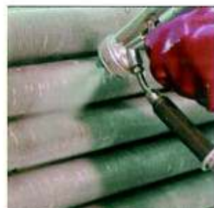
FIG. 9-10 Applicazione in cantiere su tubi alettati.
