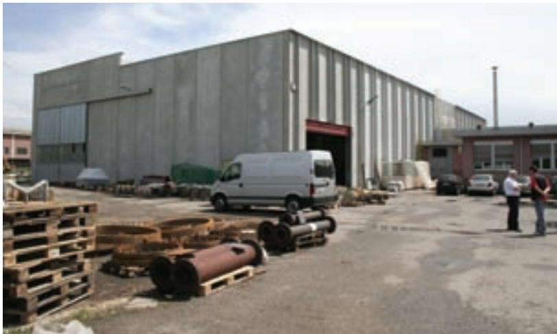
Figg. 6 e 7 - I due capannoni dell'azienda con il grande piazzale per la movimentazione. Sulla sinistra si intravede anche il magazzino vernici
